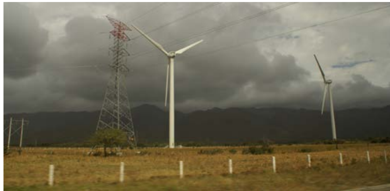
Turbinas eólicas, Parque Eólico La Venta, Oaxaca, México Wind turbines at La Venta Wind Park, Oaxaca, Mexico
