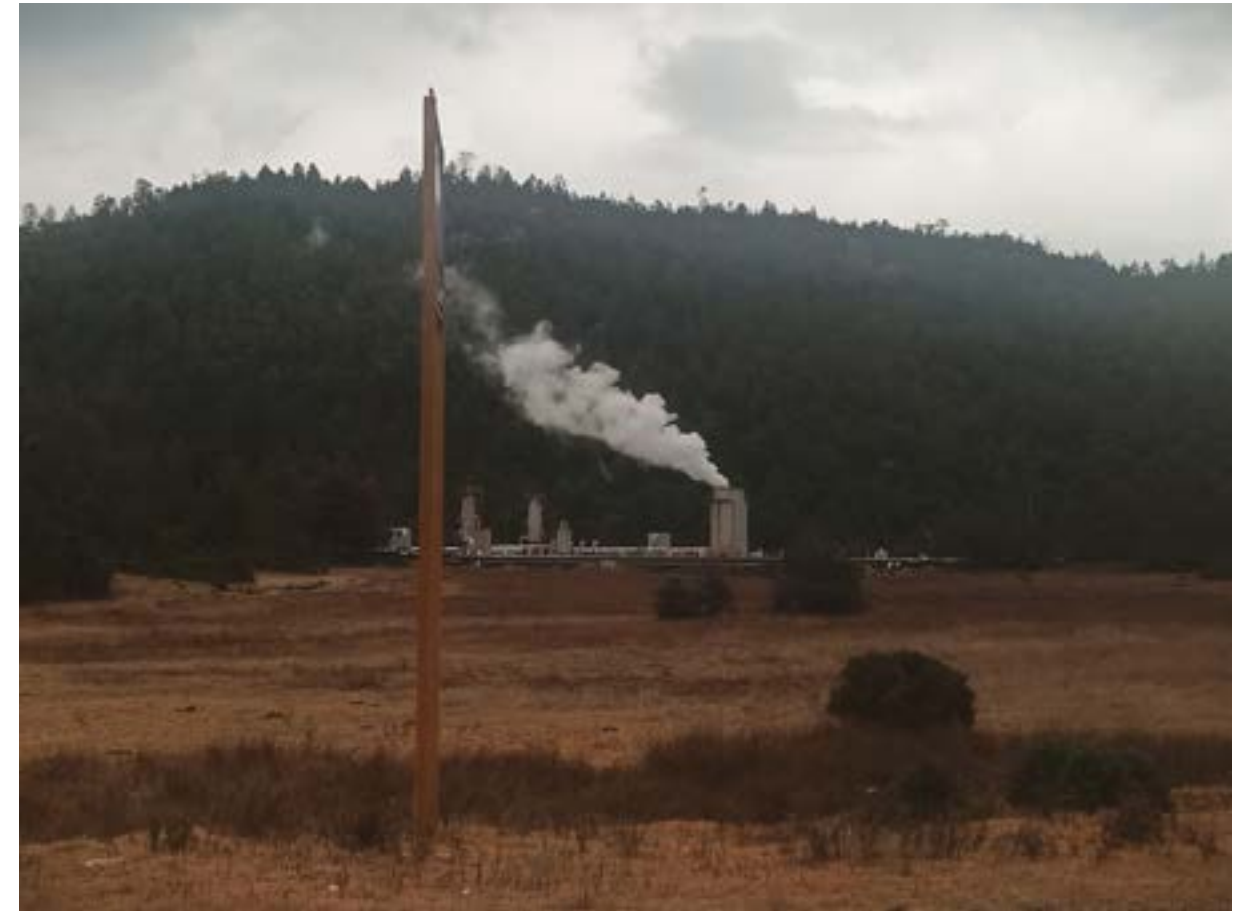
Planta de energía geotérmica en Los Azufres, Michoacán, México Geothermal energy plant in Los Azufres, Michoacán, Mexico
